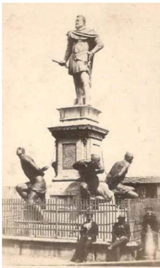
Fig. 4: Il monumento dei Quattro Mori in una foto di Alphonse Bernoud del 1865 ca. Qui i trofei ai piedi della statua di Ferdinando I sono già spariti.
